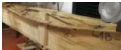
Figura 17 Separación de la guadua del patín superior.
