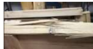
Figura 19 Falla por tensión de las fibras del patín inferior.
