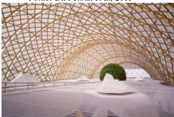
Figura 2: Gridshell feita de papelão. Pavilhão japonês da Expo Hannover 2000, Alemanha Fonte: Kuiken e Mentegazzi, 2014
