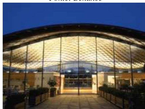
Figura 4: Gridshell em madeira do Savill Building em Surrey, Reino Unido Fonte: AtelierTen, 2007
