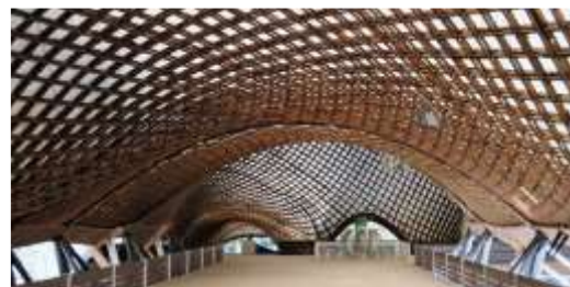
Figura 2: Vista interna da Mannheim Multihalle Gridshell , Alemanha Fonte: FASP+EPP
