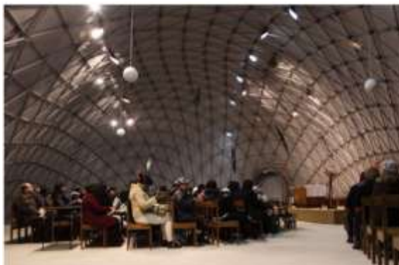
Figura 1: Gridshell construída em compósito de fibra de vidro. Ephemera Cathedral of Créteil, França, 2013. Fonte: Du Peloux et al, 2015
