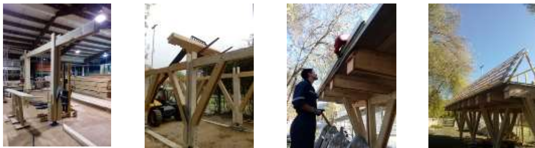
Figura 14: Fabricación y montaje de ciclovía.
