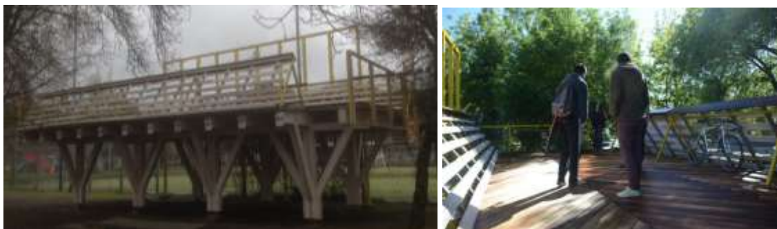
Figura 5. Vista general y a nivel superior del prototipo construido en la actualidad.
